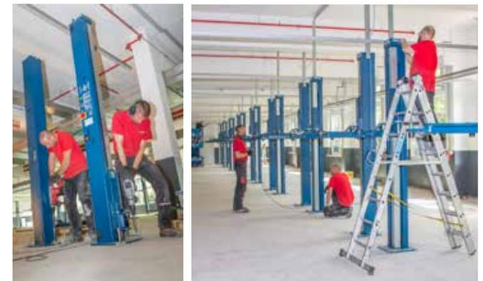
Bohrmaschinen im Dauereinsatz: Hier montieren die Techniker vom Matthies Werkstatt-Dienst Hebebühnen im Untergeschoss.
