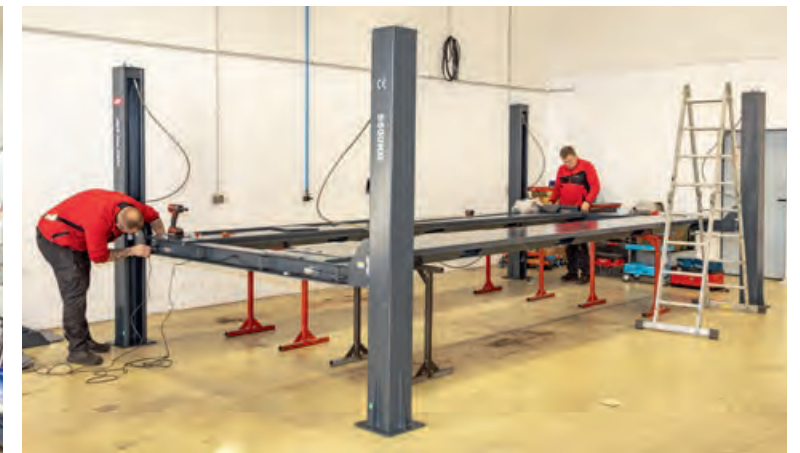
Teamwork: Nachdem die schweren Bauteile abgesetzt sind, übernehmen die beiden Techniker die Montage der JMP Fox 5500 H (r.). Die Viersäulenbühne trägt fünfeinhalb Tonnen und ist zur Aufnahme von Pkws, aber auch schweren Transportern und Wohnmobilen geeignet.
