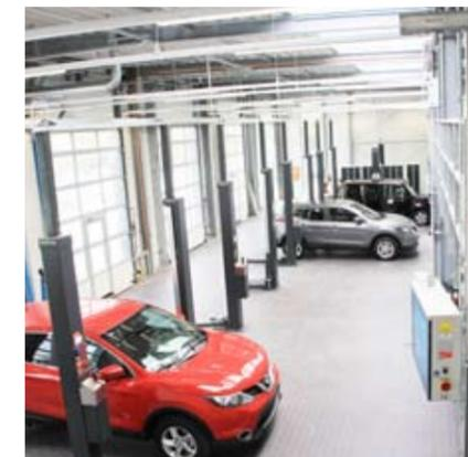
**Insgesamt sieben Bühnen:** In der Werkstatt sind fünf Pkw-Bühnen verbaut, dazu kommt eine für Transporter sowie noch eine Scheibenbühne für spezielle Arbeiten (SEP, TÜV, Achsvermessung).
