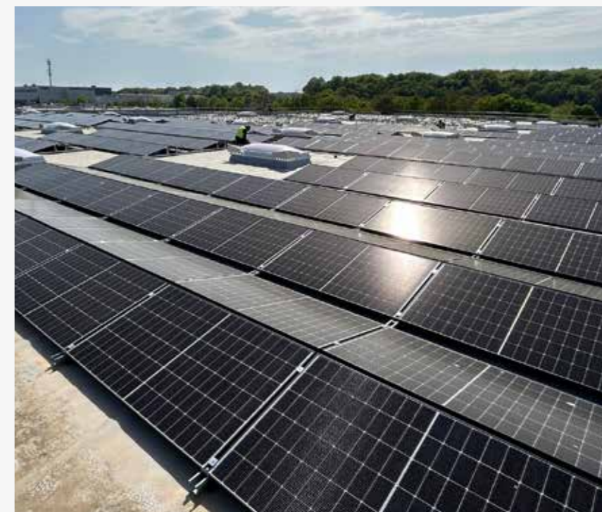
Sonnige Aussichten: Auf 2.350 Quadratmetern Fläche erzeugen 1.196 Module Strom.
