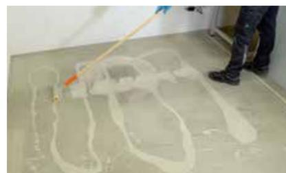
Nach dem Anschleifen das Material gleichmäßig verteilen. Wie viel Menge benötigt wird, errechnet ein Matthies-Mitarbeiter. Genau wie für den Härter.
