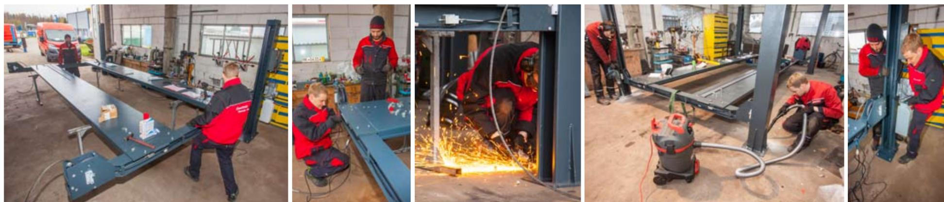
Jeder Handgriff sitzt: Die erfahrenen Techniker vom Werkstatt-Dienst bocken Teile der Bühne nach dem Abladen auf. Sie montieren Pierre Kegler flex die Schwerlastanker der Vorgänger-Hebebühne ab. Kollege Julius Ristow bohrt die neuen Befestigungslöcher, bevor beide die Säulen exakt ausrichten.
