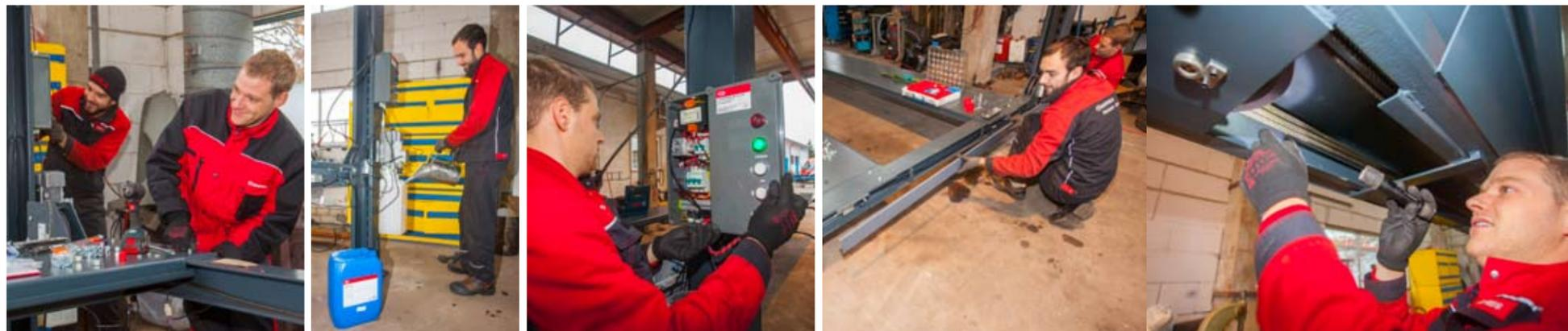
Jedes Teil muss an die richtige Stelle. Gar nicht so einfach, wenn man die Bühne zum ersten Mal aufbaut. Während Ristow Hydrauliköl einfüllt, prüft Pierre Kegler den Schaltkasten. Unzählige Kabel werden verbunden. Danach schraubt Ristow noch eine Abdeckung vorne vor. Erst nachdem alle Bauteile kontrolliert wurden, ist die Bühne betriebsbereit.
