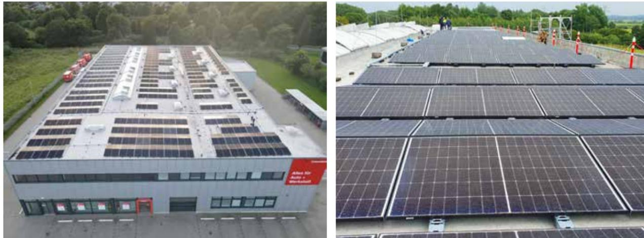
**Ideal genutzte Fläche:** Jedes der insgesamt 462 Module in Heide bringt es auf 430 Watt Peak – so heißt die Einheit elektrischer Leistung bei Photovoltaik-Anlagen. Die Solarzellen produzieren auf 900 Quadratmetern über 180.000 kWh Strom. Kosten: rund 200.000 Euro.
